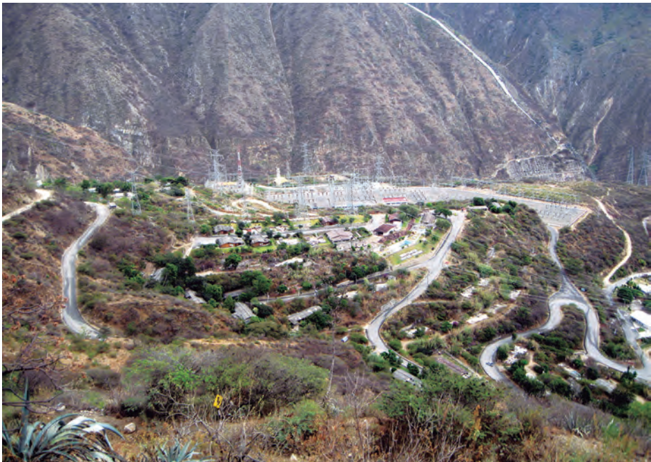
Fotografía 4: Complejo Hidroeléctrico del Mantaro ubicado en el distrito de Colcabamba, Tayacaja (Néstor Taipe, 2012).
