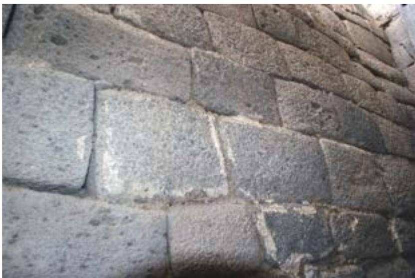
Detalle de la mampostería del muro con piedras labradas unidas con mortero de barro
