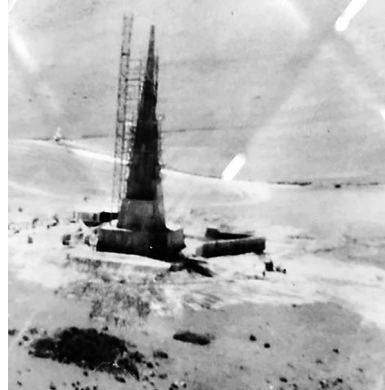
Fig. 2: Obelisco en plena construcción en la Pampa de Ayacucho, para el Sesquicentenario (Fuente: Soy Noticias # Ayacucho# Huamanga # Quinua)
